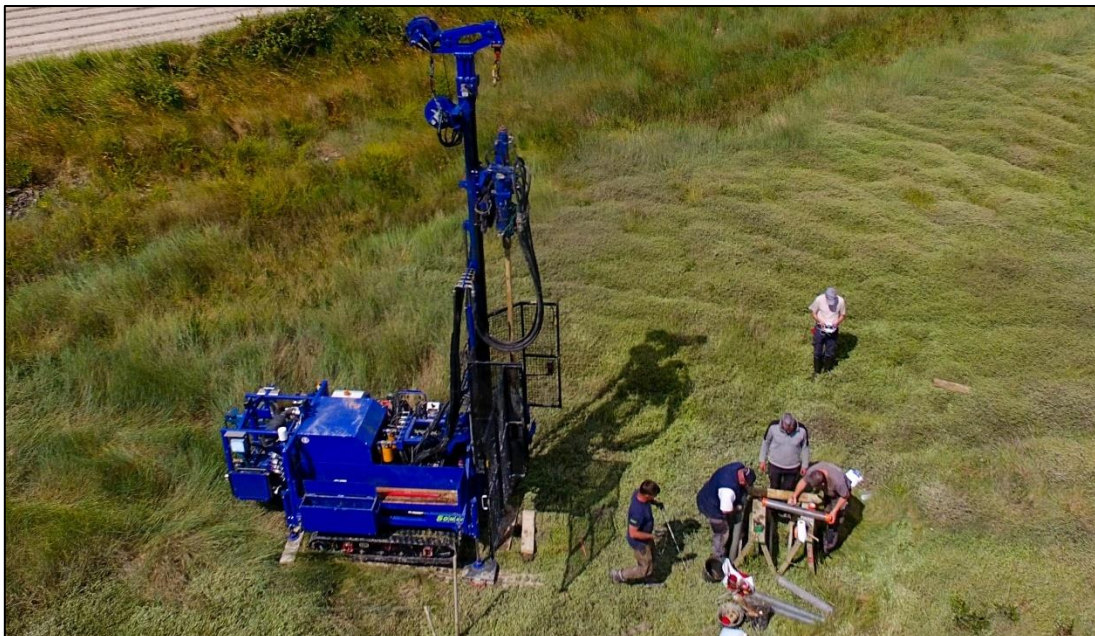
Figure 2: Foreuse SOMAC SD 250-70 sur les Grèves de Languoux.
