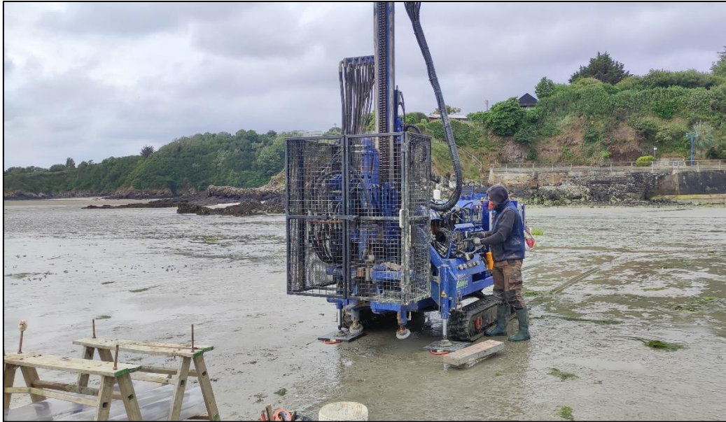
Figure 3: Foreuse SOMAC SD 250-70 sur la plage du Valais.
