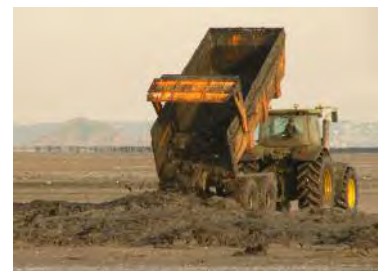
Les rejets de dragage de l'avant-port du Légué sur l'estran induit un impact sur les peuplements benthiques de la zone de rejets sur environ 60 ha.
