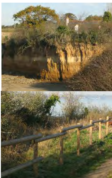
La modification de la gestion agricole au dessus de la falaise de l'Hôtellerie devrait ralentir les effondrements de la falaise.
