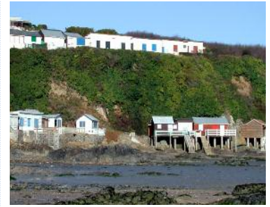
Construit illégalement sur le domaine littoral (zone NDI), les cabanons de la "cité Baby" (plage du Valais) et la "cité Monaco" (plage de St Laurent) dispose que partiellement de système d'assainissement.
